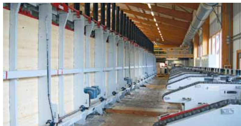
Vier Segmente besitzen die Beschickung der BSH-Pressen und die Presse selbst – damit kann die Anlage sehr flexibel belegt werden
